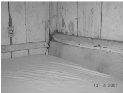
Figuras 2a e 2b - Detalhes do interior de casas localizadas próximas à fundição em Adrianópolis, PR, mostrando locais de acúmulo de poeira contaminada.
