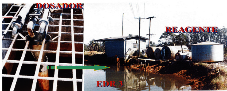
Figura 2. Vista da estação adutora e o ponto de adição dos reagentes alcalinos
