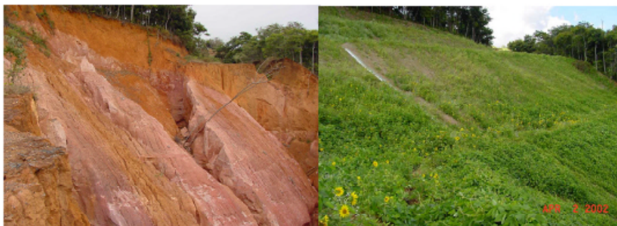
Figura 1. Imagens “antes (2000) e depois (2002)” da recuperação ambiental de uma grande voçoroca na mina de Piçarrão
