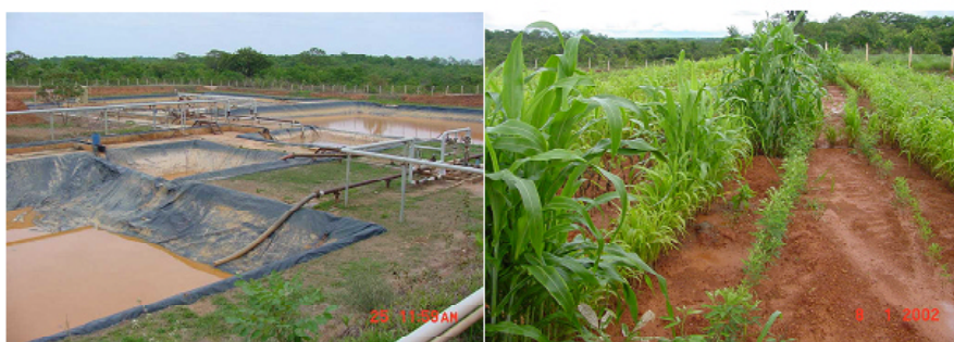
Figura 5. Imagens ANTES: (2001) Tanques de lixiviação, com a Planta em fase final de operação e DEPOIS: (2002) Área toda coberta com material das pilhas lixiviadas e com uma camada de 50 cm de solo para viabilizar a vegetação.
