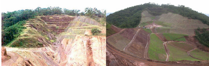
Figura 3. Imagens “antes (2001) e depois (2003)” da reabilitação ambiental em taludes na mina de Caeté
