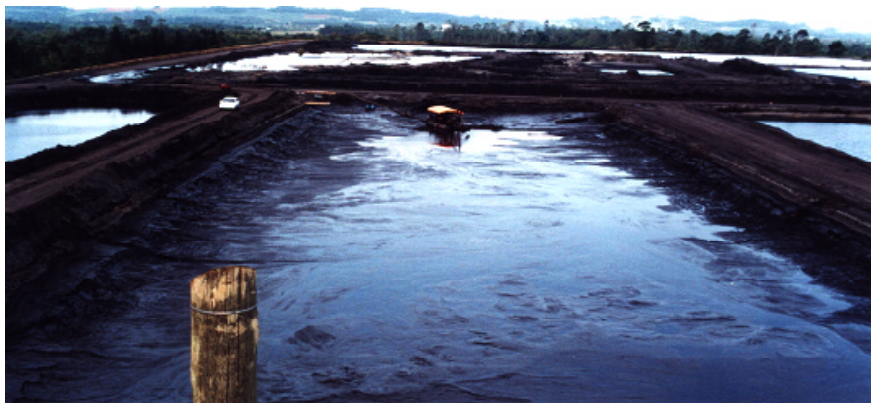
Figura 7. Aspecto da Remoção do Lodo do Decantador 2 – Módulo A
