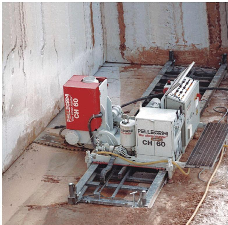
Figura 7 – Corte com serra diamantada
