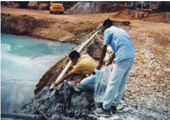
FOTO 2 – Amostragem no tubo de descarga da lama na barragem de rejeito
