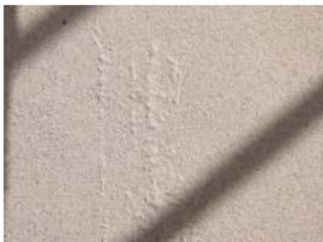
Figura 2 - Suporte saturada em fachada revestida pintada com material acrílico
