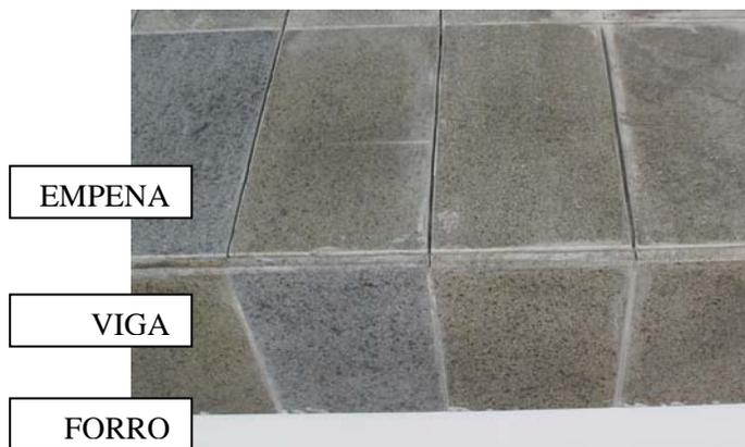
Figura nº 02 – Ausência de respingador entre a empена da fachada e o acabamento inferior da viga de bordo.
