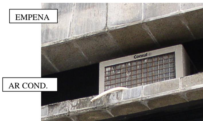
Figura nº 01 – Ausência de dreno para ar condicionado.
