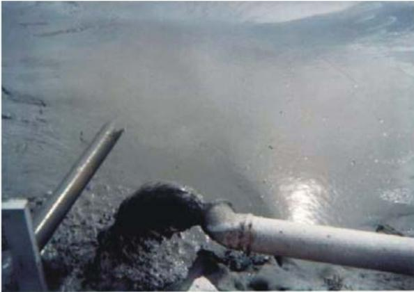
FOTO 1 – Descarga da lama na barragem de rejeito
