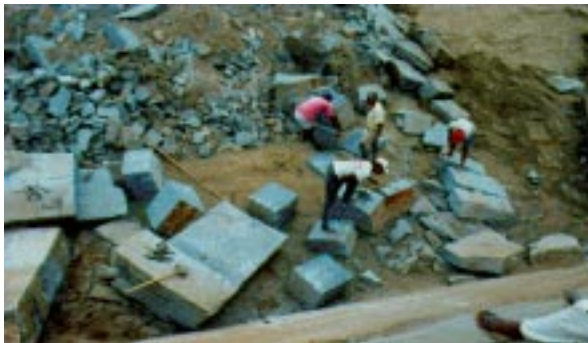
Figura 1 – Vista geral do trabalho de divisão de blocos, em pedreira de Pádua
