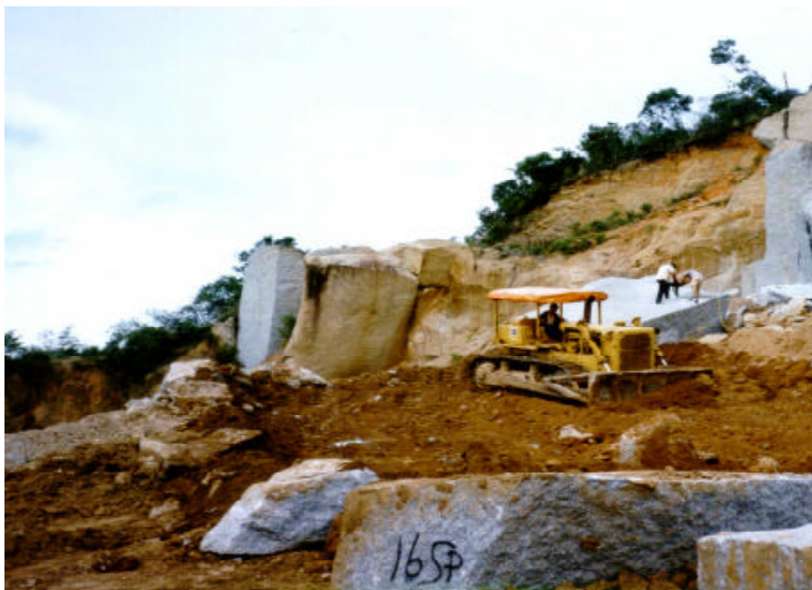
Figura 7 – Lavra de rochas ornamentais em matacões, Rio Grande do Sul. Pedreira desenvolvida sem planejamento e pouco mecanizada
