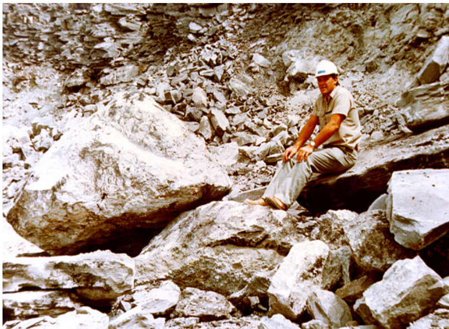
Figura 5 – Geração de grandes matacos no desmonte de rochas
