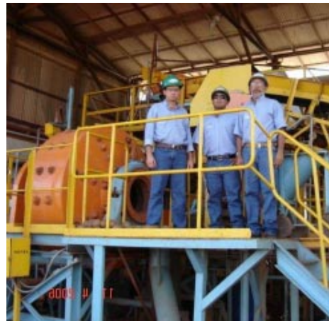
Foto 2 - Unidade piloto do CETEM para a moagem semi-autógena em Paragominas - Vale.
