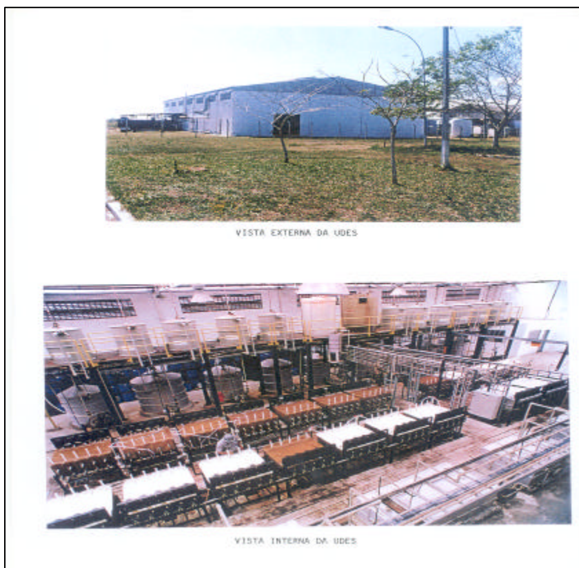
Figura 3 – Vistas externa e interna da UDES – Unidade de Demonstração de Extração de Solventes, em Buena (RJ).
