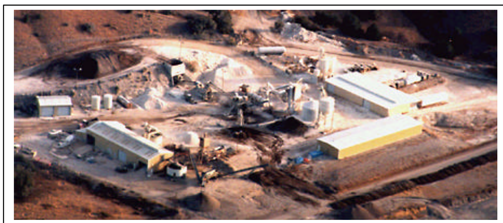
Figura 7 – Vista parcial das instalações da usina Sant Cloud nos EUA.
