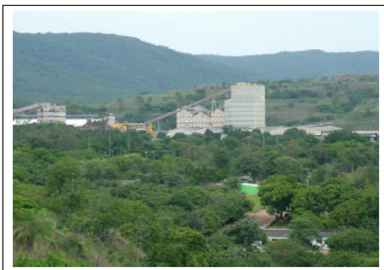
Figura 4 – Vista geral da área industrial.
