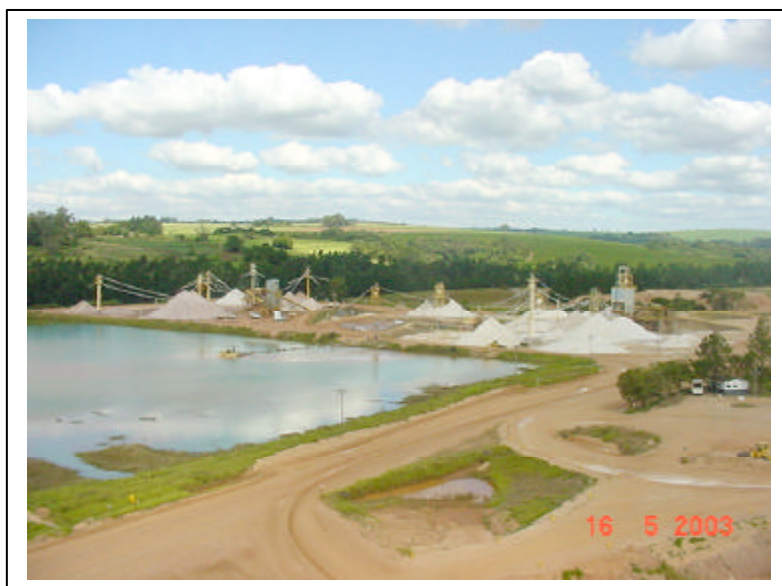
Figura 2 – Vista da bacia de rejeito e usina de beneficiamento de areia da Mineração Jundu, Descalvado-SP.
