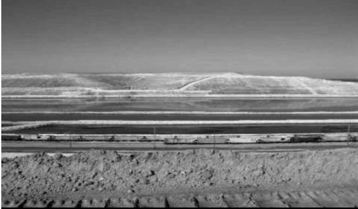
Figura 1.2 – Vista panorâmica de um dos 20 sítios de disposição de fosfogesso na Flórida (último plano) e suas respectivas lagoas de decantação. Em segundo plano, servindo de escala, um trem de carga
