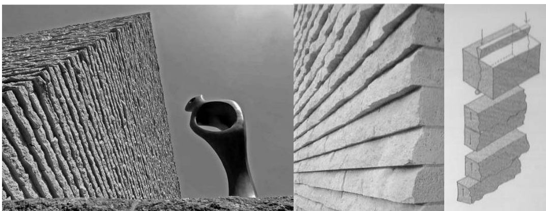
Fotos 06 - Museu Wurth detalhe de fechamentos e modulação de blocos de rochas.
