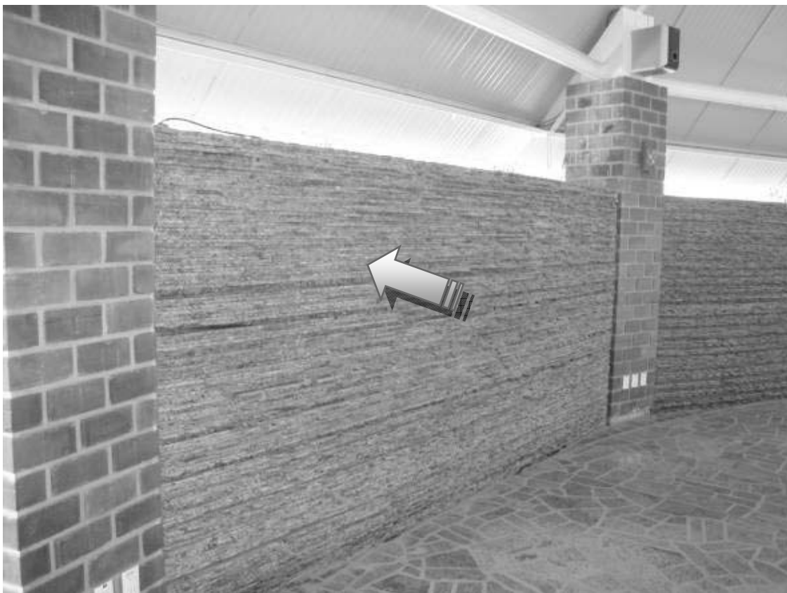
Figura 07 – Painel em Tiras aplicadas. Materiais diversos assentes com argamassa, flamados no local e resinados, formando painel monocromático. (Obra Jaciguá, 2007. Foto do autor).
