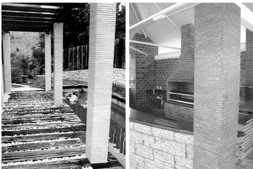
Figura 07 – Colunas em Tiras aplicadas. Assentes com face serrada para Fora. (Obra R. Azevedo, 2005 – Obra Jaciguá, 2008 - Fotos do autor).
