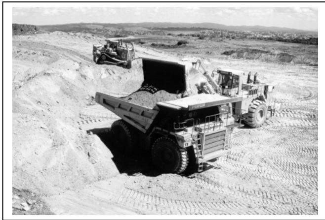
Figura 12 – Sistema carregadeira frontal/caminhão usualmente empregado em pedreiras com trator dando suporte em operações auxiliares.
