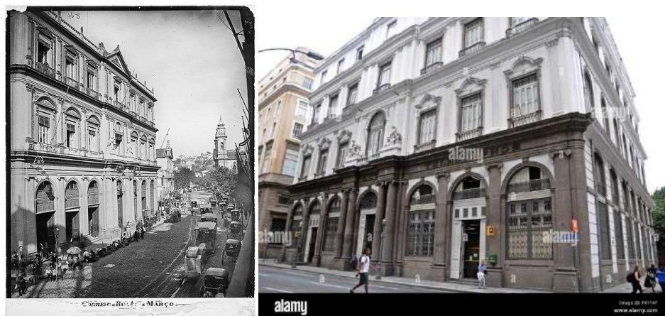
Figura 1A: Prédio dos Correios em 1743. Figura 1B: Prédio dos Correios em 2023.
