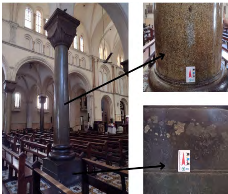
Figura 16. Localização das alterações colorimétricas nas colunas da Paróquia de Santo Afonso.
