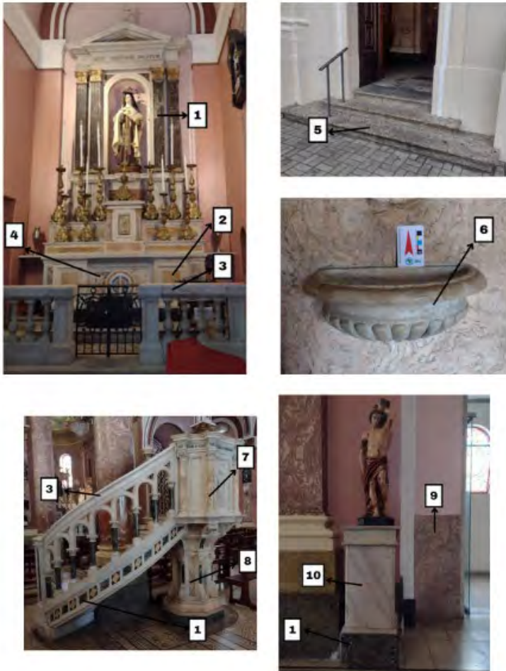
Figura 10. Litotipos encontrados na Basílica Santa Teresinha do Menino Jesus: 1) Verde Alpi; 2) Giallo Sienna; 3) Mármore Carrara; 4) Mármore Sete Lagoas; 5) Gnaiss Facoidal; 6) Lioz; 7) Ônix; 8) Pele de Onça; 9) Mármore Branco Cachoeiro.
