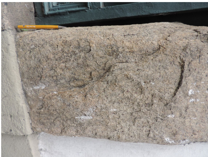
Figura 12. Descamação.
