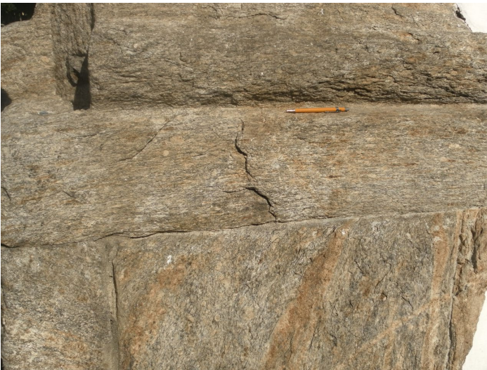
Figura 11. Descamação.
