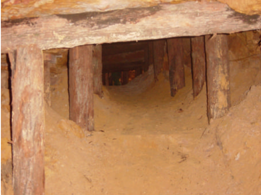
Figura 8 - Escoramento e aterro realizado na galeria abaixo da residência
