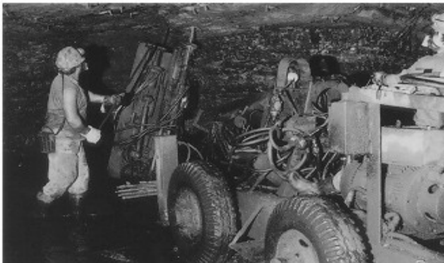
Figura 4 – Perfuratriz de teto com colocação de um parafuso por m^2
