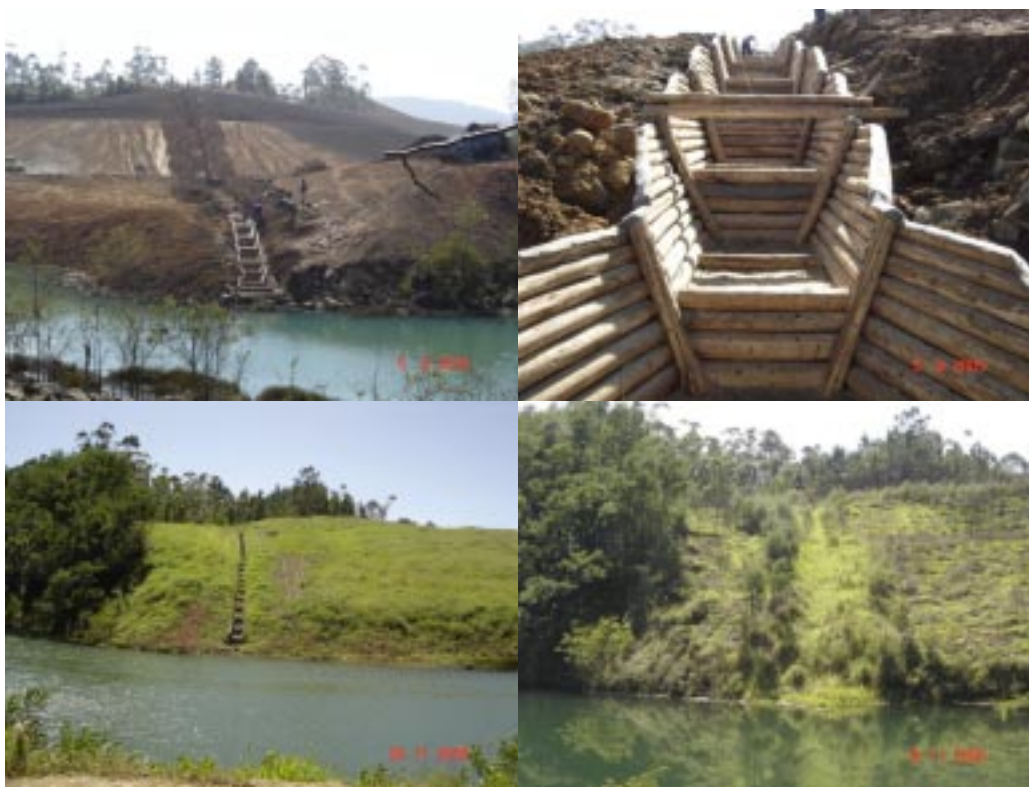
Figura 8 – Drenagem naturalística implantada nas áreas em recuperação
