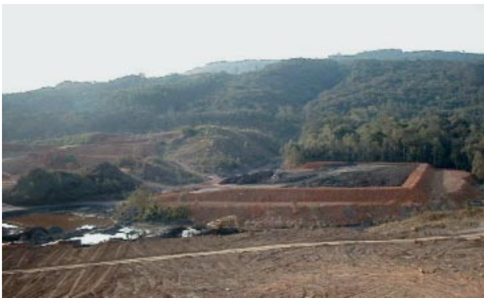
Figura 5 – Implantação da “célula de rejeitos” no campo
