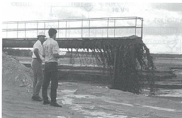
Figura 4: Barragem de rejeitos da usina de concentração da mina Caraíba
