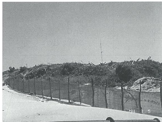
Figura 4: Quebra-ventos: auxiliam o reflorestamento da duna de rejeito da MILLENNIUM.
