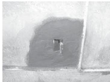
**Figura 14** – Argamassa com lama Abrasiva
