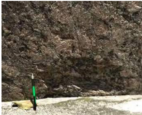
Figura 47. Escamação resultando na perda de massa.
