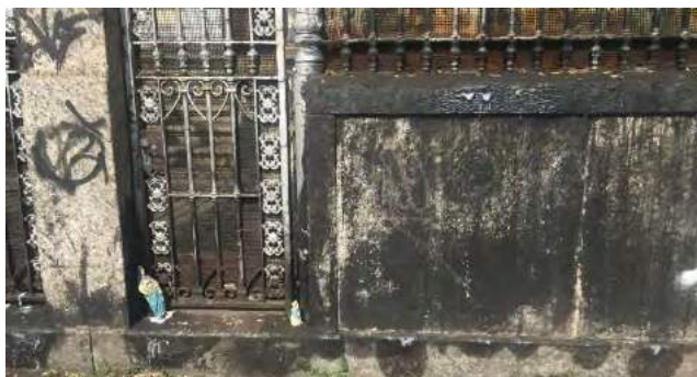
Figura 60. Pilastra com grafites no Mosteiro Nossa Senhora da Conceição da Ajuda e manchamento preto provocado pela cera das velas que ali são acesas e por depósitos provenientes da queima de combustíveis dos ônibus.
