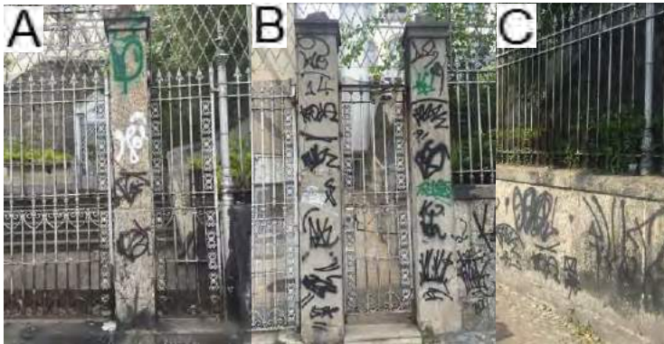
Figura 19. Fachada do Mosteiro: (A) coluna em gnaiss facoidal; (B) colunas de alvenaria; (C) muros e colunas em gnaiss facoidal.
