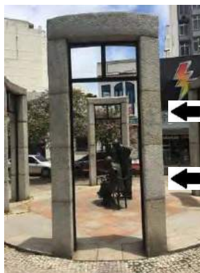
Figura 58. Arco das pilastras 1 (direita) e 2 (esquerda) com alteração cromática nos blocos inferior e no terceiro de baixo para cima em 1.
