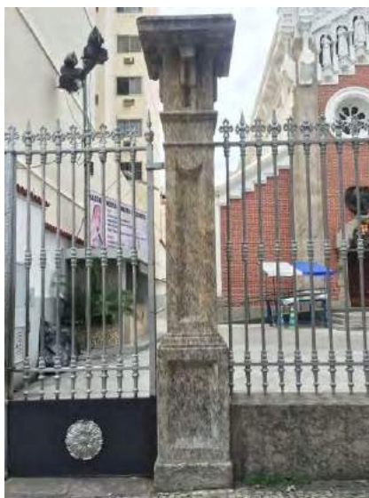
Figura 48. Pilastra da Basílica Nossa Senhora de Lourdes com alteração cromática amarelada ocorrendo na porção superior.
