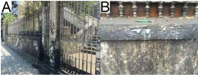
Figura 51. (A) Depósitos de coloração escura; (B) parafina de vela derretida em cima do muro.
