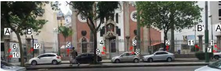
Figura 28. Distribuição de pontos de ensaio na Basílica de Nossa Senhora de Lourdes e orientação utilizada no mapeamento de danos.
