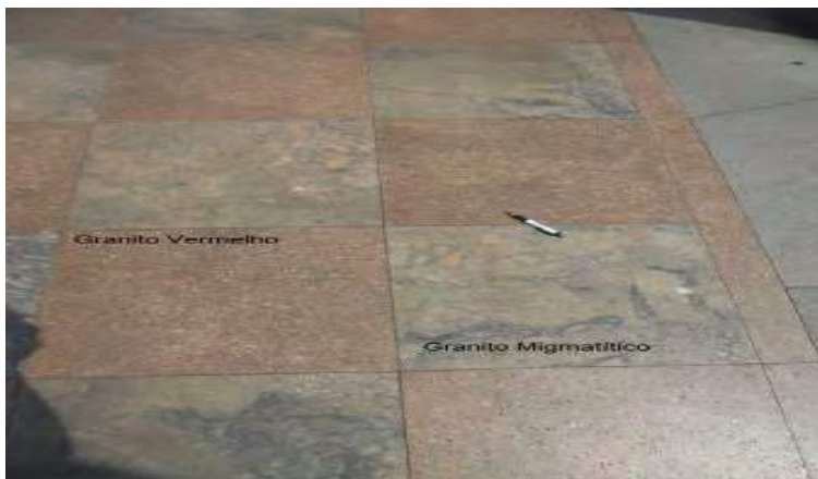
Figura 14. Piso do monumento a Noel Rosa, composto por granito migmatítico e granito vermelho organizados em "xadrez".
