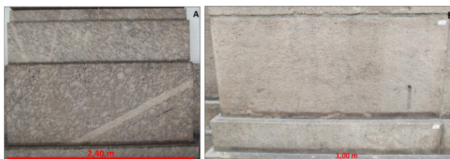
Figura 3: Tonalidade escura do Gnaiss facoidal (A) em contraste com leptinito (B), fachada da INSC.
