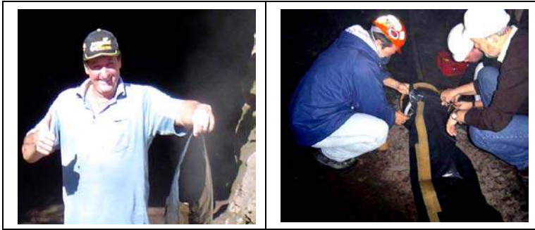
Figura 4. Preparando dutos e testando ventilação.
