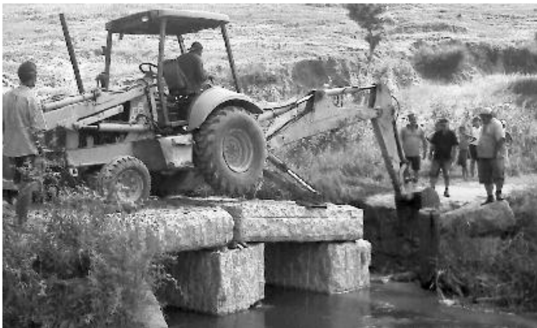
Figura 4 - Ponte construída com blocos residuais em Jerônimo Monteiro. Foto: Mario César Cunha Fialho (Prefeitura Municipal de Jerônimo Monteiro), 2011.
