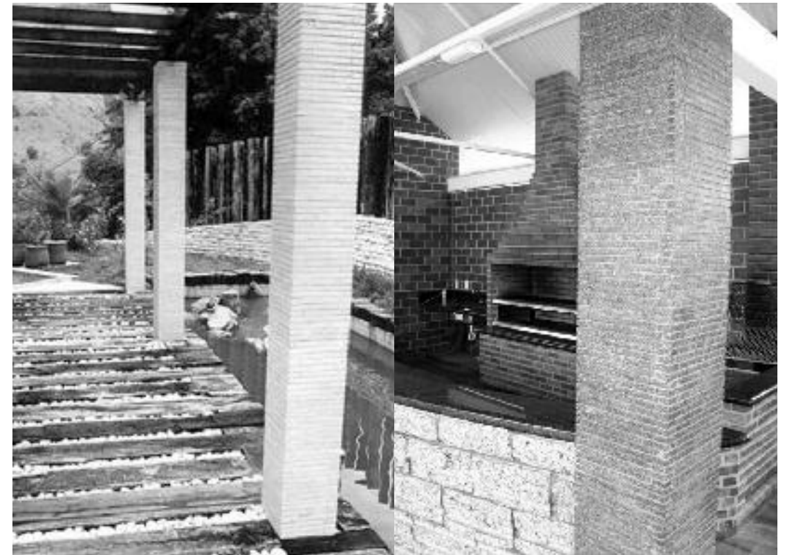
Figura 36 - Colunas em Tiras aplicadas e assentes com face serrada para dentro. Fotos: Arq. Renato Paldés, 2011.
