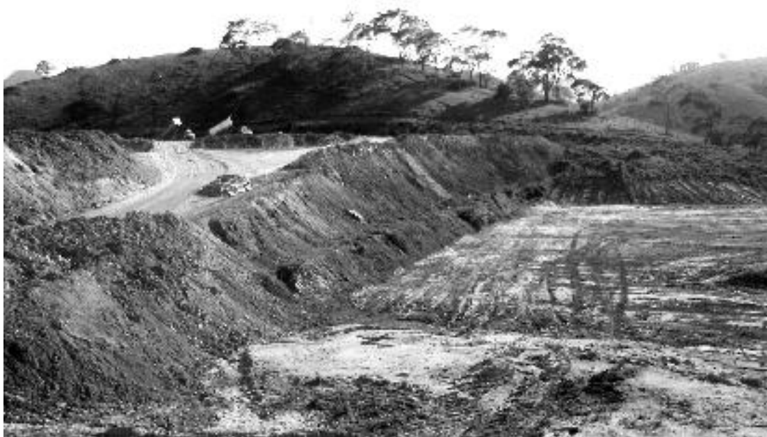
Figura 5 - Célula de deposição de finos de beneficiamento, do aterro da Associação Ambiental Monte Líbano, em Cachoeiro de Itapemirim (ES). Foto: AAMOL, 2013.
