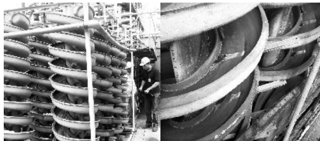
Figura 16 - Bateria de espirais (esquerda) e detalhe da calha (direita). Fotos: CETEM/MCTI, 2013.
