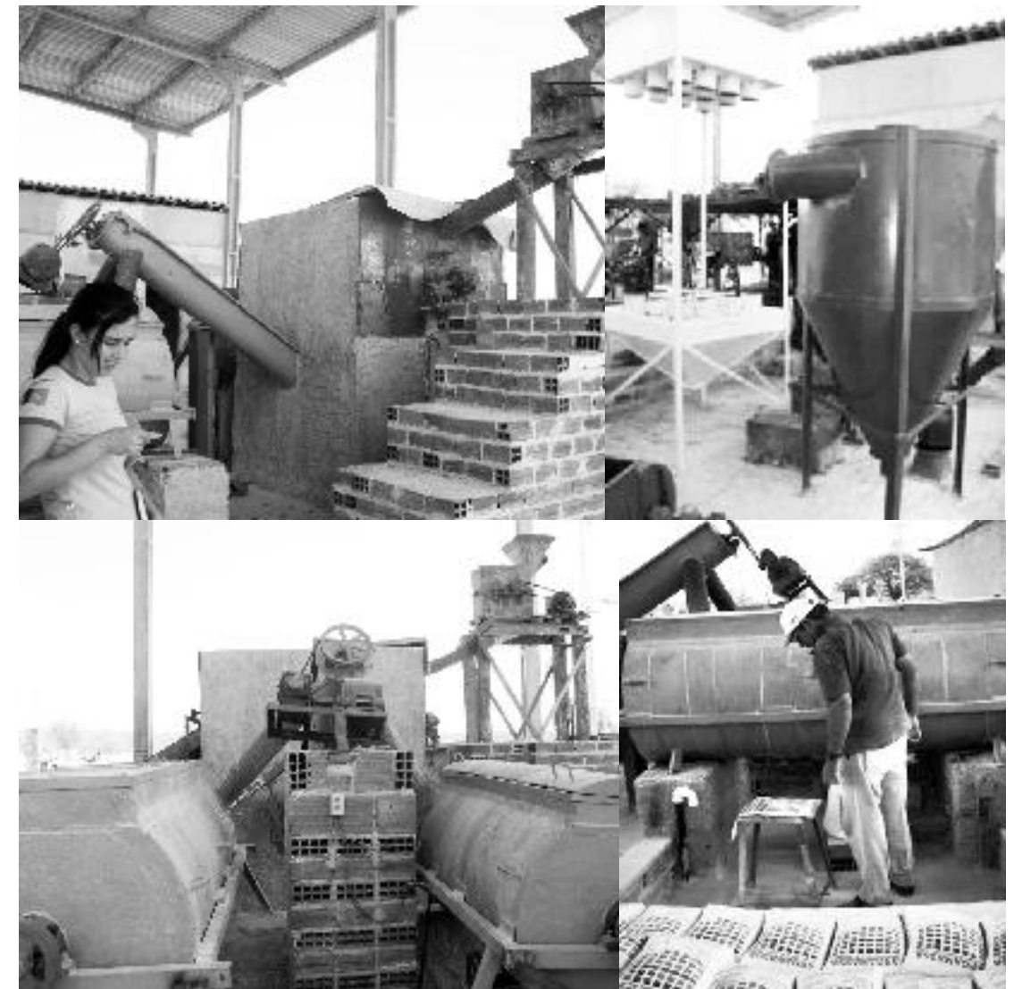
Figura 45 - Vistas parciais da usina piloto em Várzea-PB. Fotos: CETEM/MCTI, 2011.
