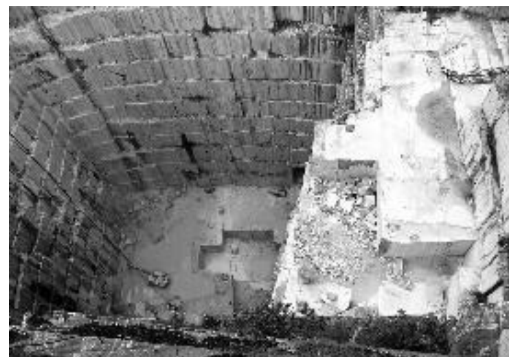
Figura 18 - Pedreira em poço, lavrada por bancadas, em Portugal. Foto: CETEM/MCTI, 2008.
