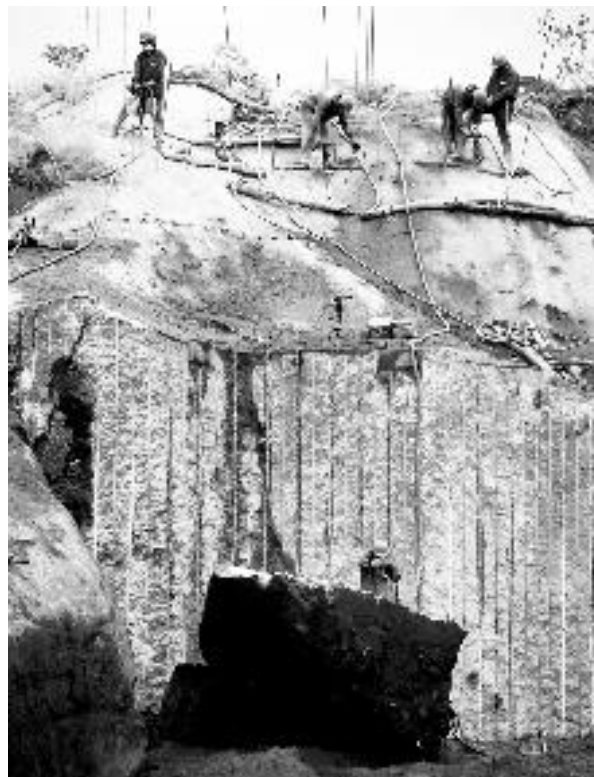
Figura 13 - Lavra de matacão de grande porte. Foto: Granitos FUJI, 2009.
