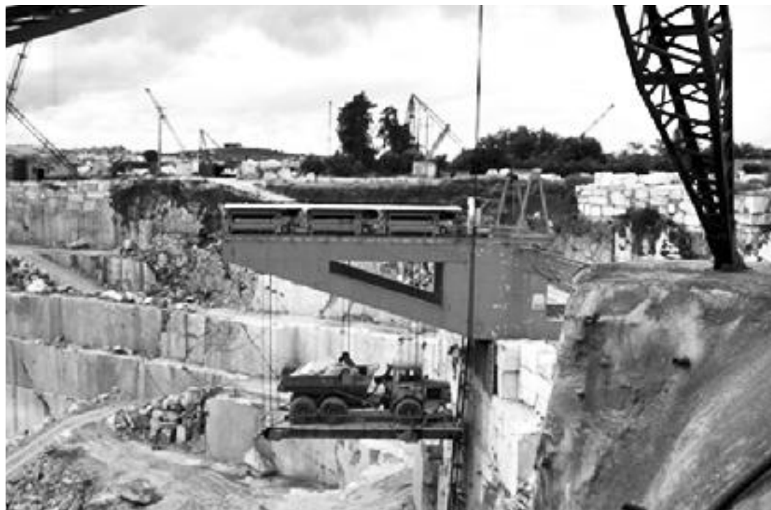
Figura 104 - Detalhe da subida do elevador utilizado para retirar estéreis. Foto: CETEM/MCTI, 2007.
