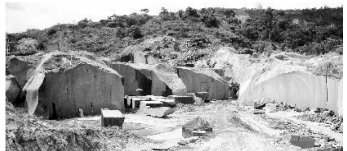
Figura 15 - Lavra de matacões com fio diamantado. Foto: CETEM/MCTI, 2012.
