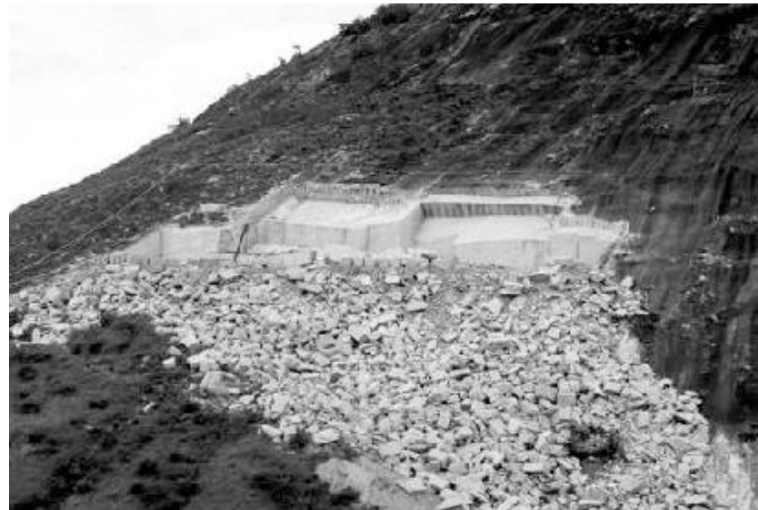
Figura 11 - Lavra por desabamento de capas artificiais. Foto: Jose Roberto Pinheiro, 2003.
