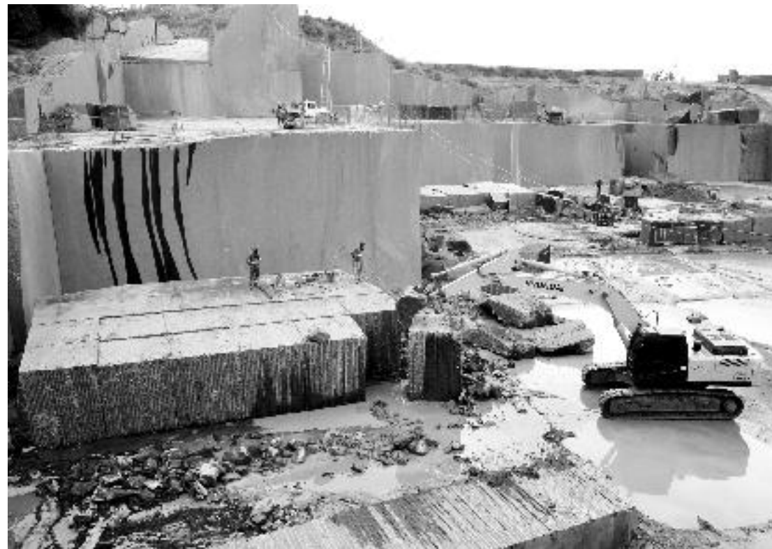
Figura 88 - Retroescavadeira usada na movimentação de blocos. Foto: CETEM/MCTI, 2012.
