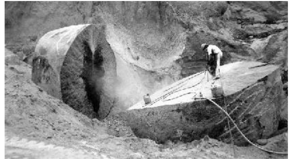
Figura 14 - Matacão dividido pela técnica do “fogo raiado”. Extraído de Marbrasa, 2011.
