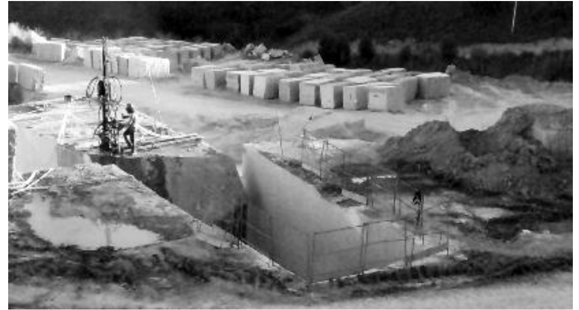
Figura 20 - Abertura de gaveta para início de exploração do nível. Foto: CETEM/MCTI, 2012.
