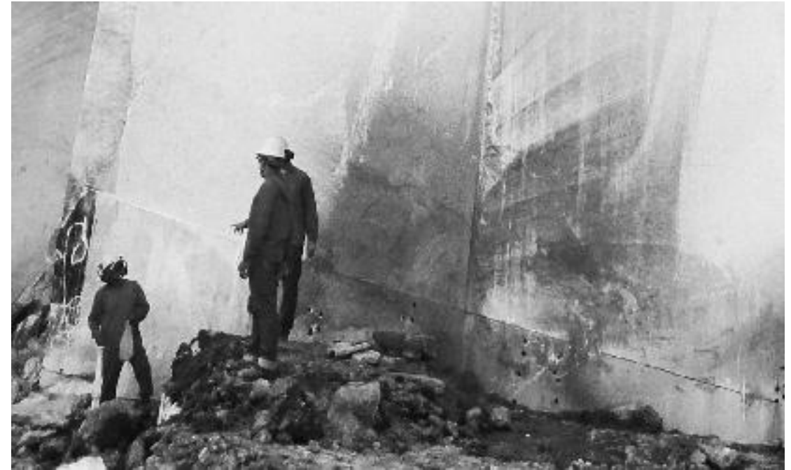
Figura 29 - Corte inclinado para descalçar o filão (boca de lobo). Foto: CETEM/MCTI, 2013.
