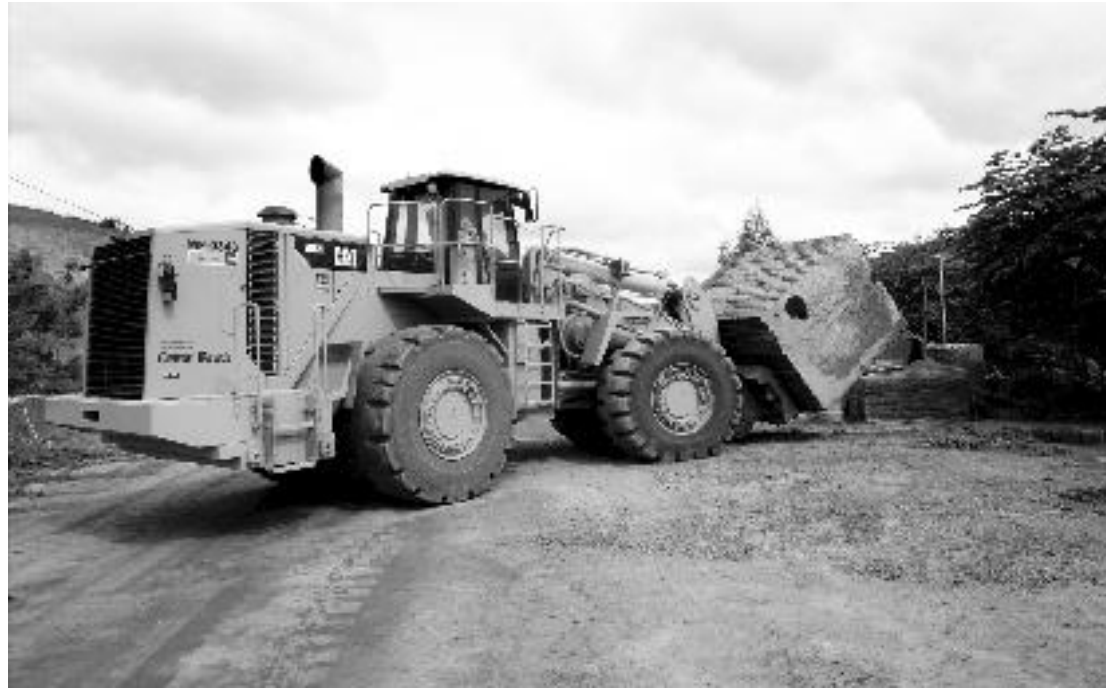
Figura 87 - Pá carregadeira usada na movimentação de blocos. Foto: CETEM/MCTI, 2012.
