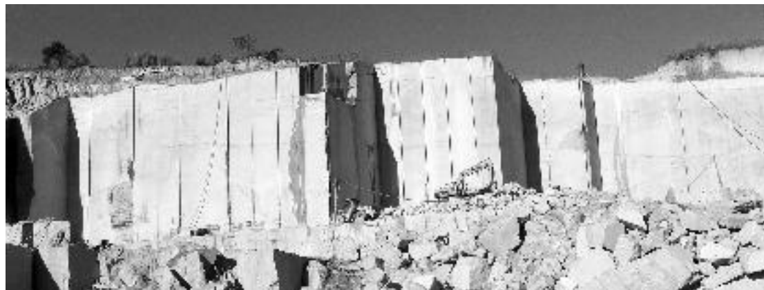
Figura 28 - Método de pranchas verticais. Notar a retroescavadeira preparando o colchão de resíduos para o tombamento. Foto: CETEM/MCTI, 2013.
