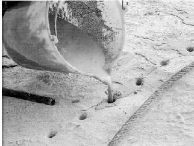
Figura 73 - Carregamento com massa expansiva em furo vertical. Foto: José R. Pinheiro, 2003.
