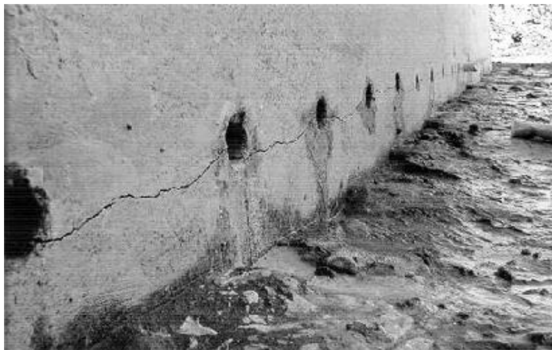
Figura 74 - Corte de levante efetuado com argamassa expansiva. Foto: José R. Pinheiro, 2003.
