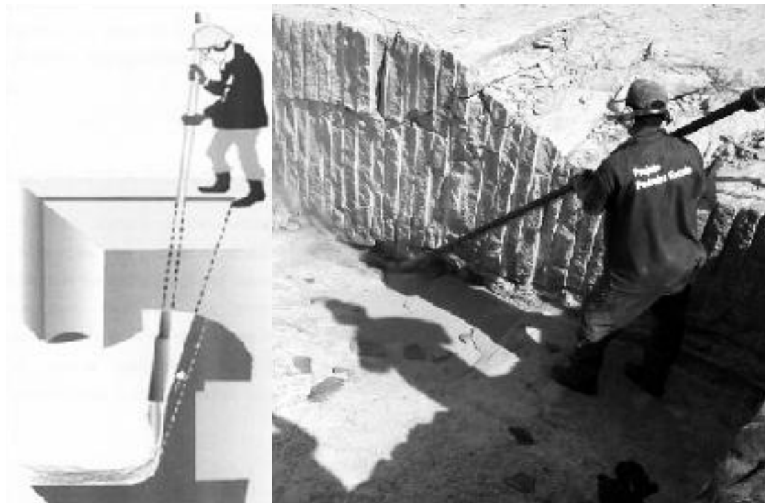
Figura 79 - Emprego do flame-jet na realização de corte horizontal. Foto e desenho: CETEM/MCTI.
