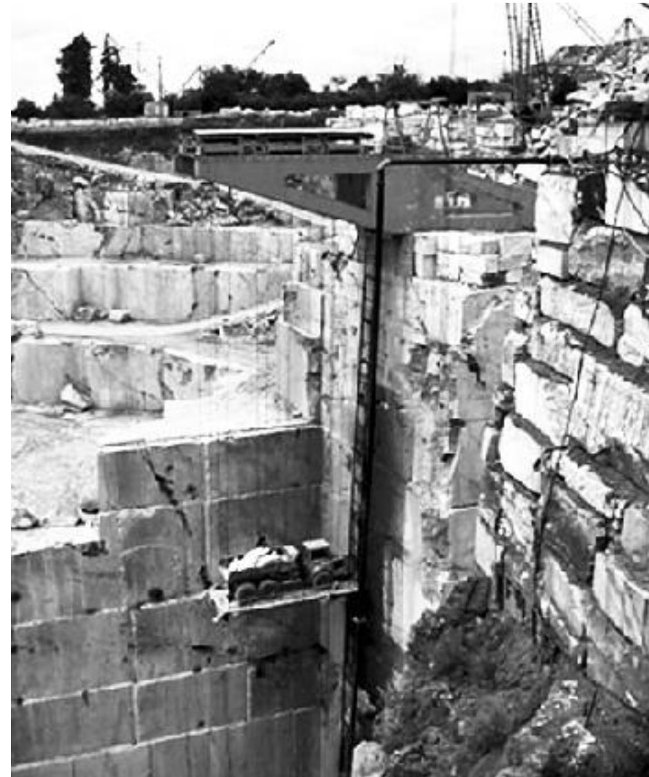
Figura 103 - Elevador utilizado para retirar estêreis da cava, em Portugal. Foto: CETEM/MCTI, 2007.
