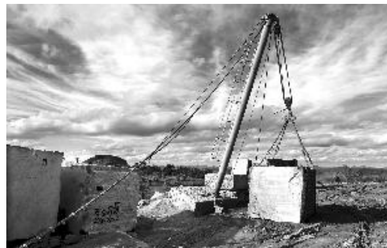
Figura 96 - Pau de carga usado na movimentação de blocos. Foto: CETEM/MCTI, 2013.
