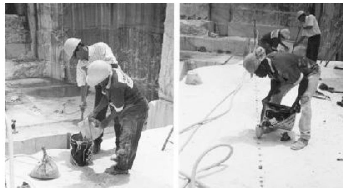
Figura 72 - Preparação e aplicação de massa expansiva. Foto: José R. Pinheiro, 2003.
