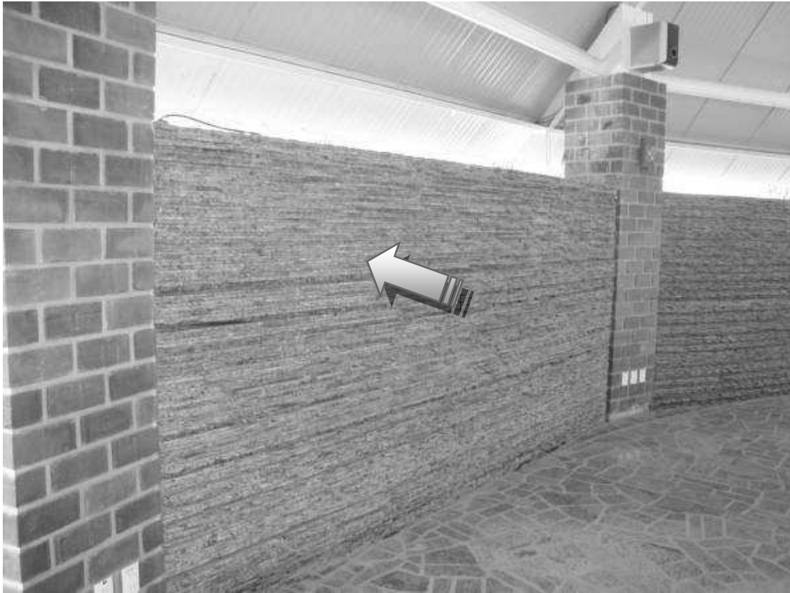
Figura 07 – Painel em Tiras aplicadas. Materiais diversos assentes com argamassa, flamados no local e resinados, formando painel monocromático. (Obra Jaciguá, 2007. Foto do autor).
