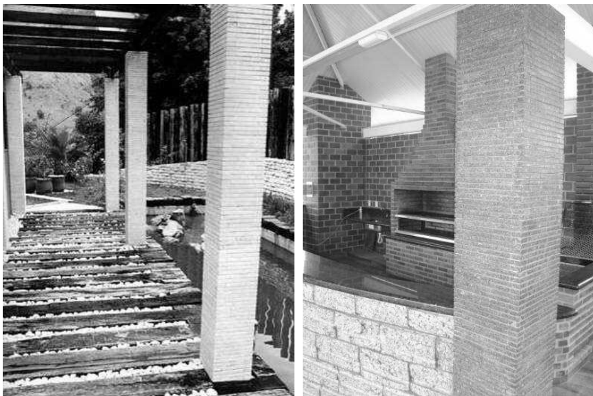
Figura 07 – Colunas em Tiras aplicadas. Assentes com face serrada para Fora. (Obra R. Azevedo, 2005 – Obra Jaciguá, 2008 - Fotos do autor).
