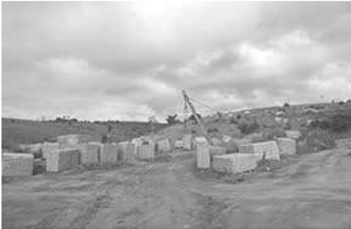
Figura 01 – Jazida de extração de blocos. Cortes efetuados pelos martelos pneumáticos, gerando falta de prumo e esquadro ao bloco que será serrado na indústria. Devido ao valor de mercado do material, alguns blocos – para seu melhor aproveitamento – também não atingem o tamanho padrão. (foto Nemer S/A.)
