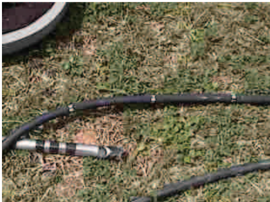
Foto 4 – Detalhe do cabo com a numeração de posicionamento
