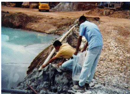
Figura 3 – Amostragem no tubo de descarga da lama na barragem de rejeito
