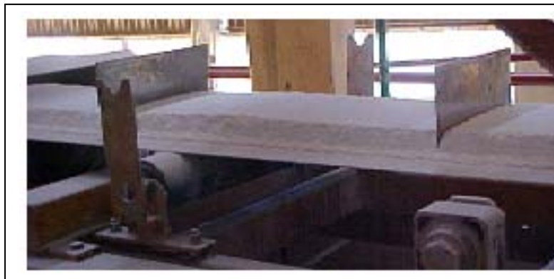
Figura 4 – Procedimento de amostragem em correia transportadora parada.
